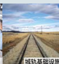
城轨基础设施
